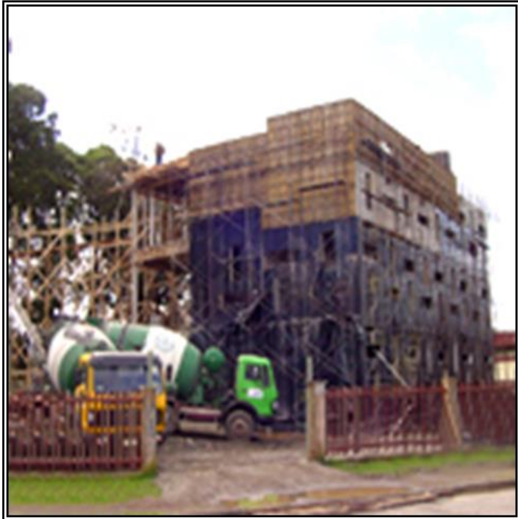
Construcción de una escuela.
