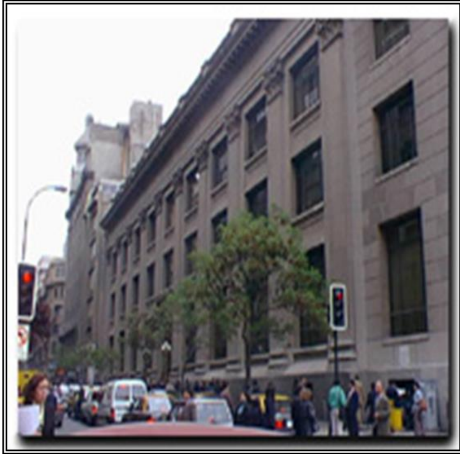
Edificio del Banco Central
